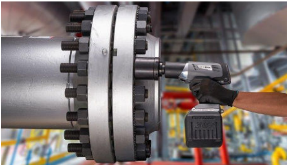
Avec les visseuses à batteries
